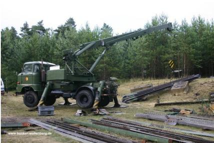
Einrichtung der Baustelle mit Kranwagen und Masteeinzelteilen
